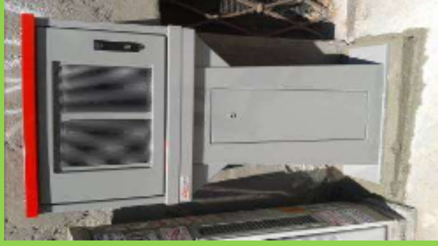
Sopralzo con ONU Cab 48 porte installato su colonnina
