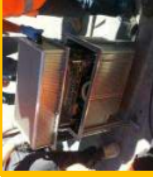
Sopralzo con ONU Cab 48 porte installato su colonnina
